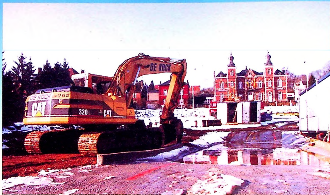
"COEUR DE VILLE" EN CHANTIER
