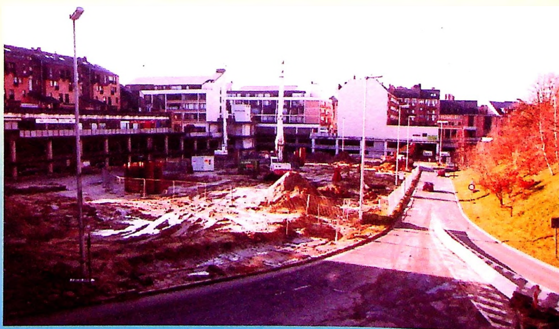
"WILHELM & CO" EN CHANTIER
