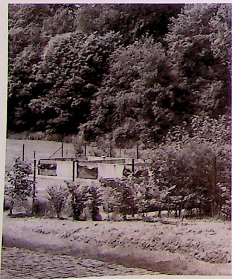
Céroux. Station d'épuration.
