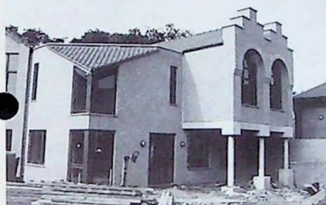
Nouvelle école des Coquerées au cours des travaux de construction.
