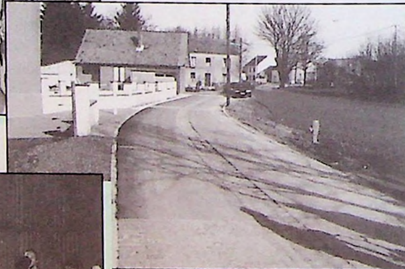
► La nouvelle voirie dans le quartier de la Baraque
