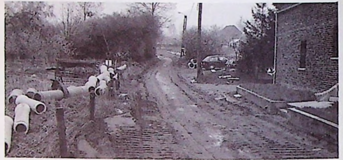
Rue de la Baraque à Louvain-la-Neuve, en chantier
