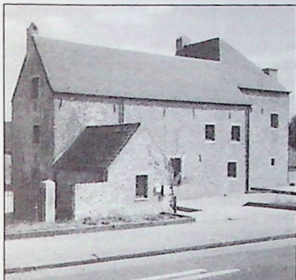
La Ferme du Douaire rénovée abrite les locaux de la Bibliothèque
