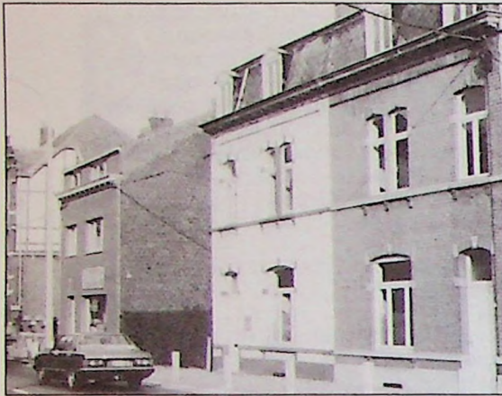
Comme beaucoup d'autres, l'immeuble abritant les services du Bulletin Communal et de l'Urbanisme a été acquis dans de bonnes conditions.
