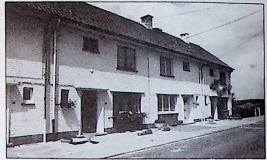
Comme à Cérroux-Mousty ou Limelette, ces maisons de l'avenue du Tienne à Ottignies, construites à l'initiative de l'Habitation Moderne, ont un petit air bien accueillant.
