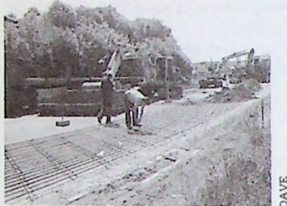
Ouverture de nouveaux chantiers, pour une plus grande sécurité.
