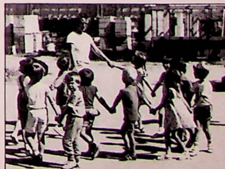
6. Rondeau au pied de la nouvelle école de Blocry en construction.
