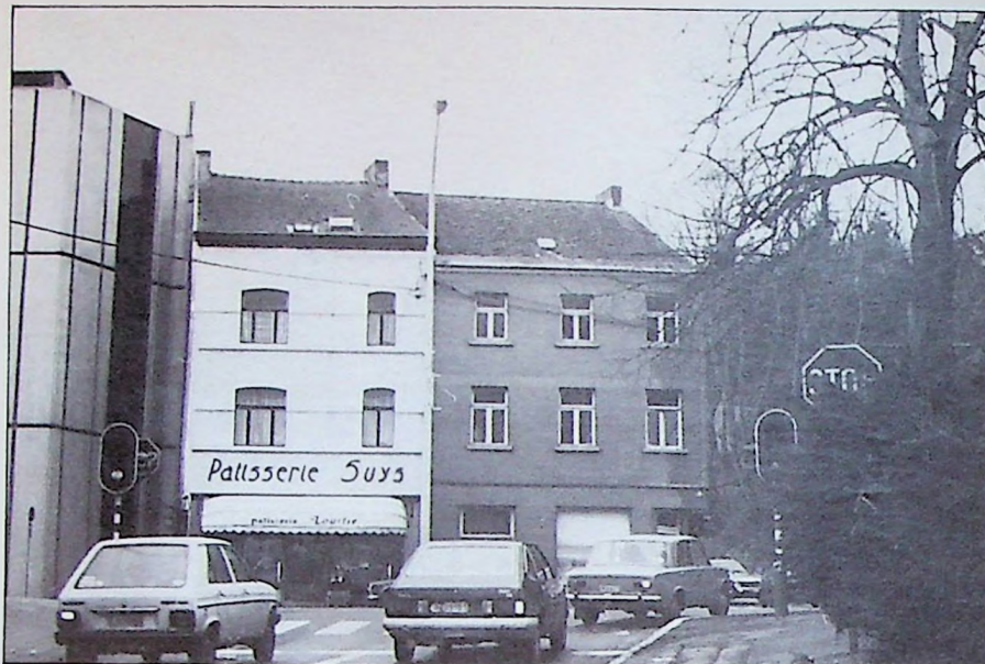
Deux témoins du passé démolis au cours du 1 er semestre de 1985 pour permettre le dégagement du carrefour de la rue du Roi Albert
