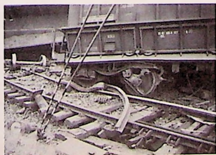
L'état des voies après le déraillement. On peut juger de l'importance des dégâts et constater la formidable poussée exercée par les wagons qui sont enchevêtrés. Le morceau de rail tordu en donne une idée.
