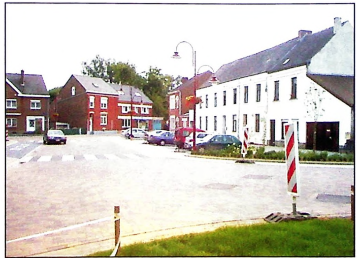
La place de l'Europe à Limelette : un projet coûteux et techniquement raté.
