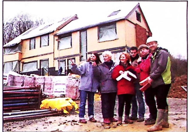
Les futurs habitants du Bois del Terre se retrouvent chaque semaine sur le chantier.
