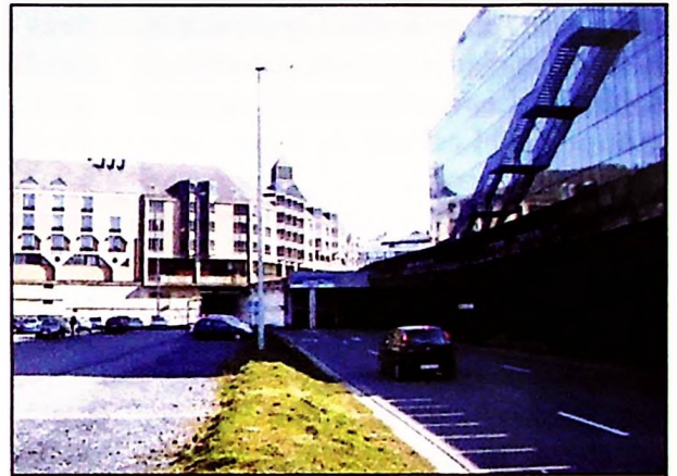
Le désenfumage des voiries souterraines d'accès au centre de Louvain-la-Neuve divise les conseillers.
