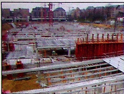
Vue sur les parkings en construction avec, dans le fond, la place de l'Accueil. Impressionnant !
