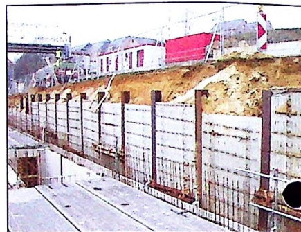
Les «parois berlinoises» installées en bordure du chantier permettent de soutenir les terres existantes et de maintenir ainsi la circulation sur le boulevard de l'Est.
