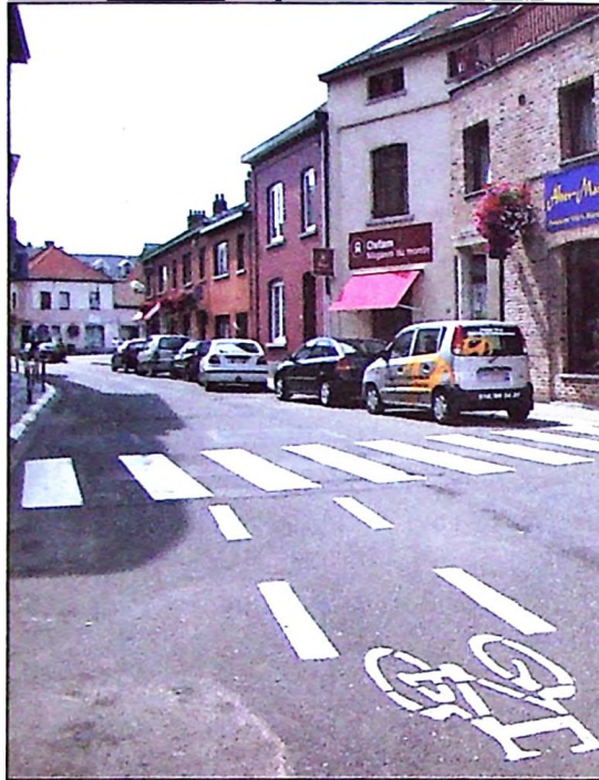
Au boulevard Martin, rue à sens unique pour les voitures, les cyclistes sont désormais autorisés à rouler à contresens.
