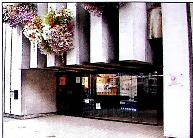
Une enseigne lumineuse sera bientôt installée au-dessus de la porte d'entrée du Centre Culturel d'Ottignies.
