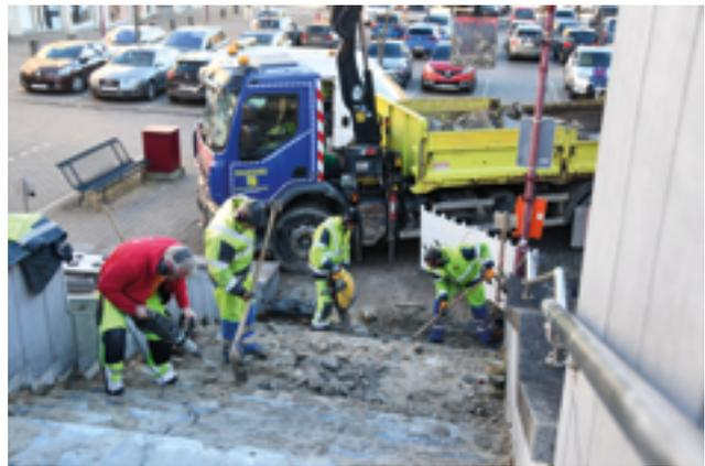
confirme que les petites réparations d'urgence effectuées à l'aide de béton à prise rapide n'ont pas tenu, les hivers passés. Sans doute que le béton initial n'était pas de bonne qualité, malheureusement.
