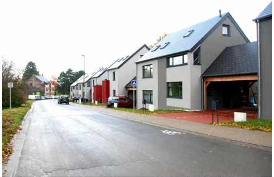
Le chantier de l'avenue des Vallées s'est terminé en 2018.
