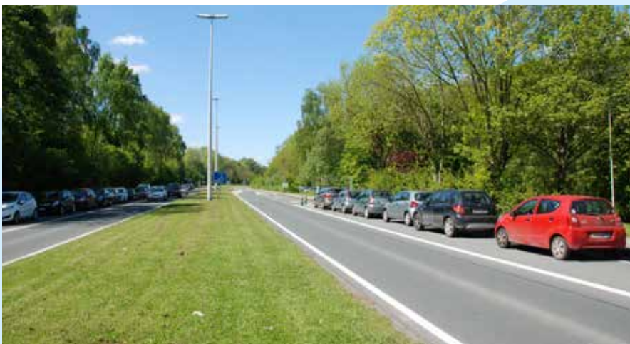
A l'initiative de la Ville, une bande de circulation a été déclassée de part et d'autre du boulevard de Lauzelle. On peut y stationner gratuitement.
