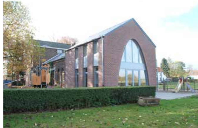
Un beau châssis, mais qui a posé quelques problèmes, dans l'extension de l'école de Céroux.
