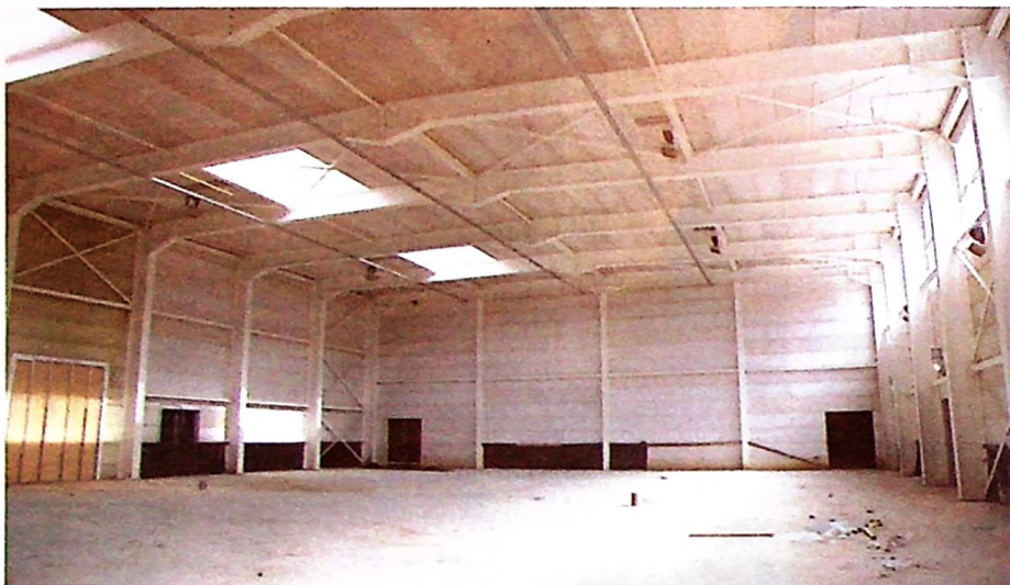
Reste à poser le revêtement de sol et à amener l'équipement, dans la nouvelle salle du centre sportif.
