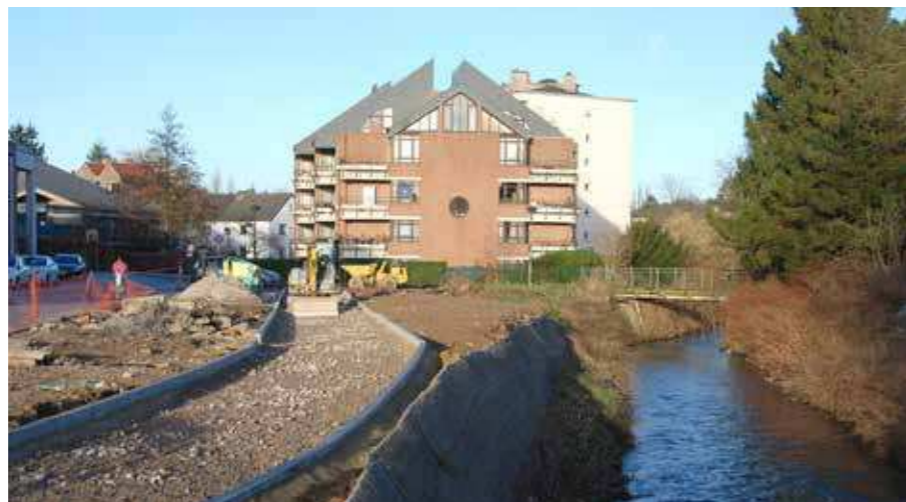
Aménagement du cheminement cyclo-pédestre «Les berges de la Dyle», à l'arrière du Douaire.
