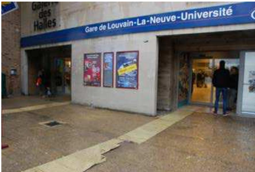
Les dalles podotactiles en caoutchouc se décollent, comme on le voit ici, à hauteur de la gare de Louvain-la-Neuve. Il est prévu de les remplacer par des dalles en béton, avec la participation de l'UCL.
