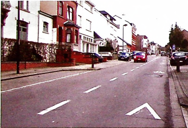
Chevrons blancs à la chaussée de La Croix.
