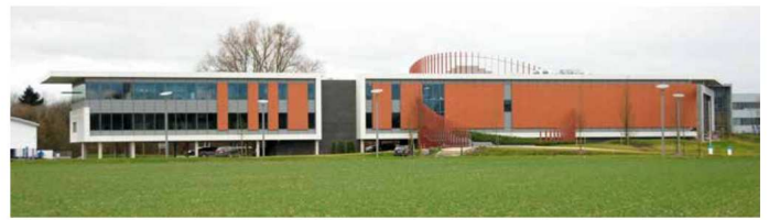
Le nouveau bâtiment du Cercle du Lac.
