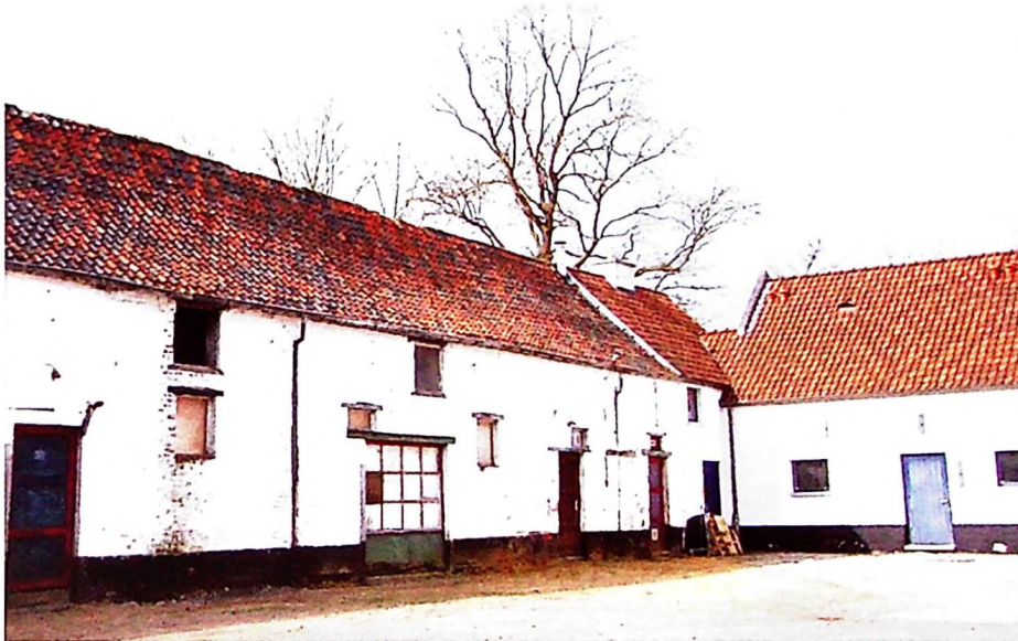
Les écuries de la Ferme du Biéreau (côté gauche de notre photo) doivent être rénovées
