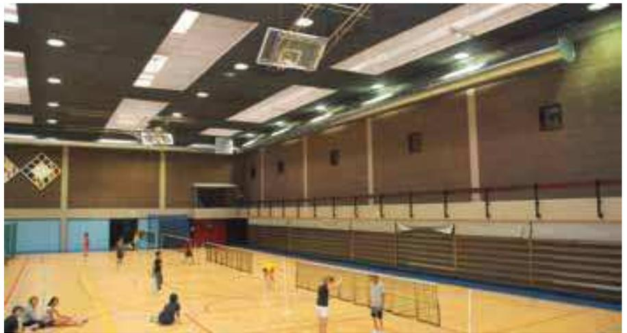
En salle H1, on découvre les nouvelles gaines (au plafond) qui assureront la qualité de la ventilation et du chauffage.
