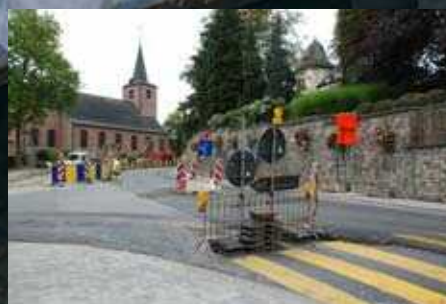
Avenue des Combattants Réouverture plus tôt que prévu
