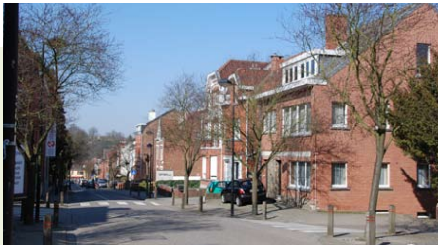
Les acacias et prunus de la chaussée de La Croix seront remplacés par des Robiniers Vibra Quisifora ou Myrtifolia et d'autres essences de type Ginkgo Biloba au niveau des ralentisseurs.
