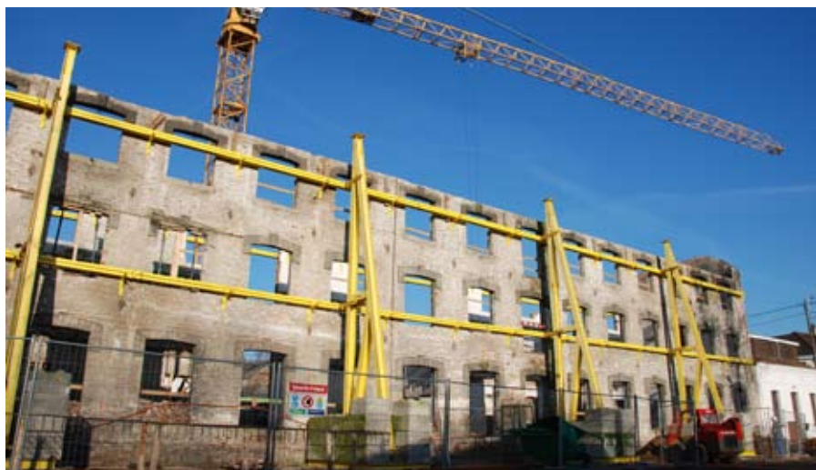
De grands travaux dans l'ancienne mégisserie de Mousty, où seront aménagés 16 appartements à loyer modéré.
