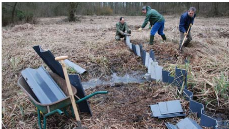
La construction de barrages à l'aide de planches en PVC.
