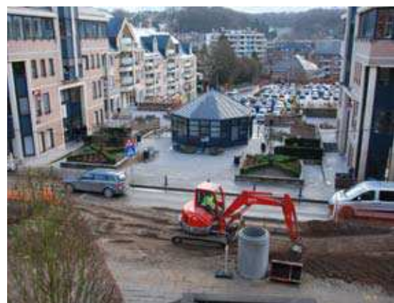
Le chantier de l'avenue des Combattants (Ottignies) se poursuit, avec l'aménagement de l'esplanade du Cœur de Ville.
