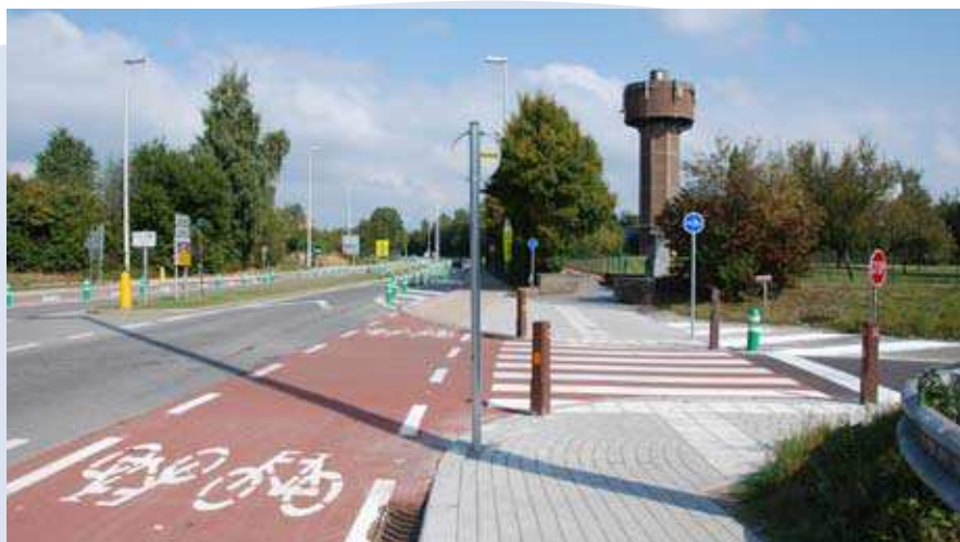
De nouveaux aménagements «modes doux» au pont du Pape.
