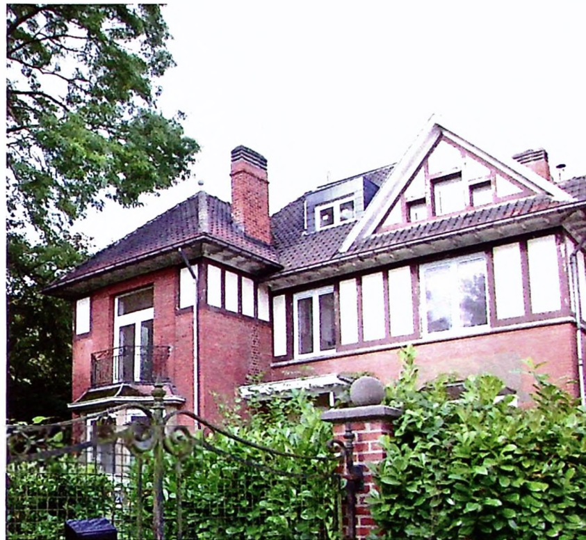
La Maison Communale d'Accueil de l'Enfance (MCAE) « Les Colibris » devrait s'installer dans la villa située à l'angle de la rue de Franquénies avec la rue des Technologies (Mousty), début 2011.
