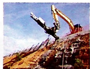
La paroi gunitée est fixée à l'aide de « clous » de 8 à 10m de long.
