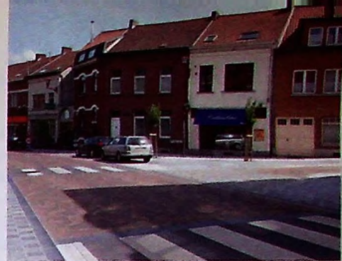
Les voiries du centre d'Ottignies viennent d'être réaménagées.
