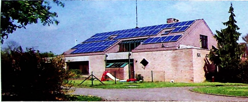
Des panneaux photovoltaïques sur le toit de la Maison de l'Enfance.
