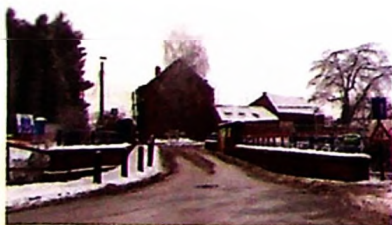
Le pont de l'avenue de Jassans.
