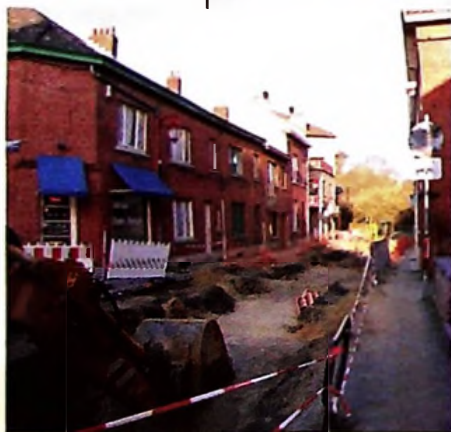
Le boulevard Martin en chantier.
