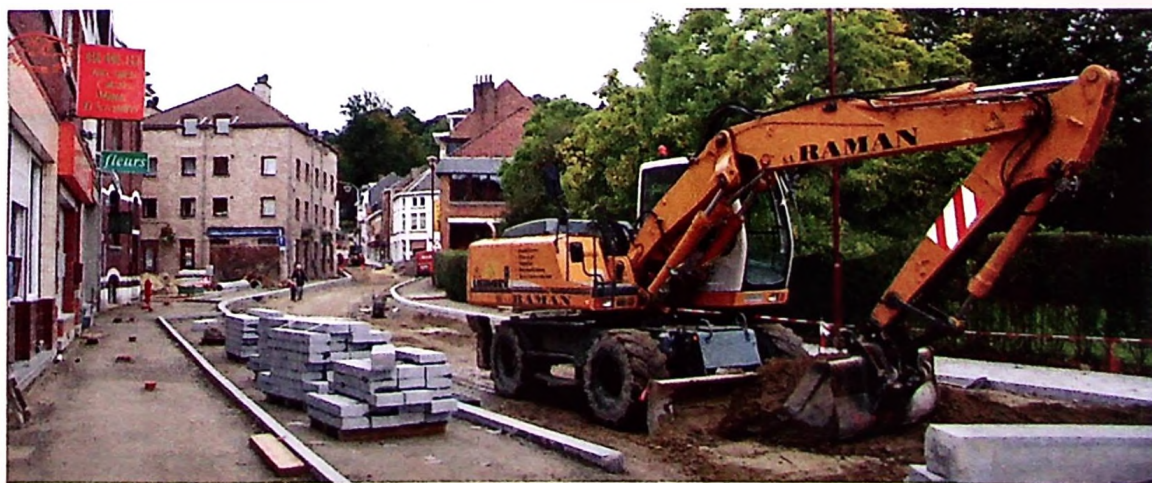
L'avenue Reine Astrid en chantier, début octobre
